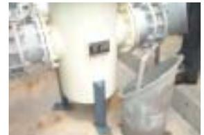
写真9 冷凍機設備熱交換器のストレーナ
